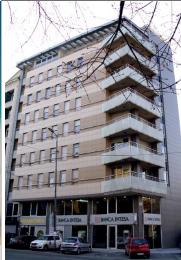
Belgrado, Yu. Bulevar, aislamiento térmico de techos y balcones, buhardilla
