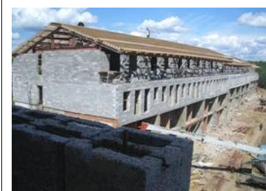
La región de Moscú, sanatorio, cuatro edificios con el área >8.000m 2 , bloques, placas y monolito Simprolit.
