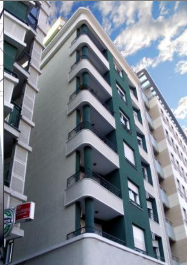
Belgrado, Yu. Bulevar, edificio residencial, fachada de placas SOP
