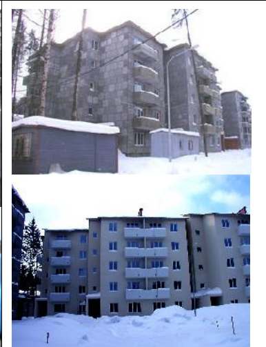
La región de Moscú, aislamiento térmico de edificios residenciales, placas SUP y SOP.
