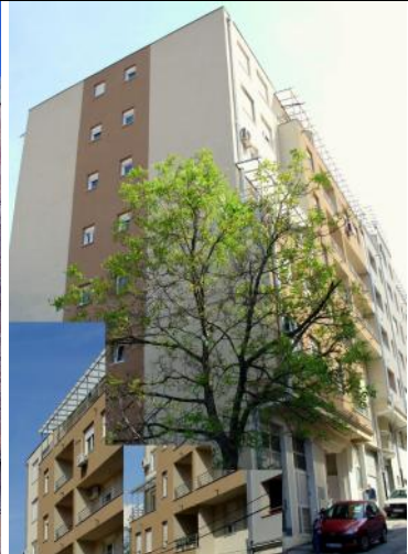
Belgrado, Zvezdara, edificio de ocho pisos con las paredes de carga hechas de bloques Simprolit sin columnas y vigas adicionales, bloques Simprolit, placas SOP y monolito Simprolit.
