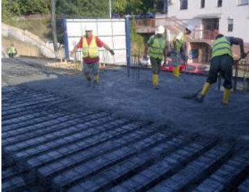
Belgrado, „Kanarevo Brdo“, edificio residencial con eficiencia energética – placas de entrepiso y revestido Simprolit, bloques de fachada y para tabiques, placas SOP para el aislamiento térmico de las columnas y consolas de balcones, monolito Simprolit para el techo.
