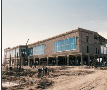
Chukotka , aeropuerto Anadyr, bloques Simprolit, placas SUP, placas de entresuelo y aislamiento térmico de techos Simprolit
