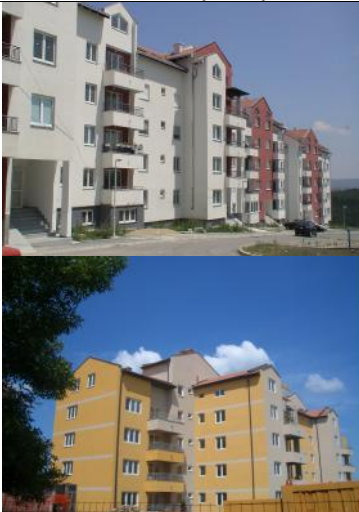
Belgrado, zona residencial „Sremchitsa“ hecho de bloques Simprolit y placas SUP
