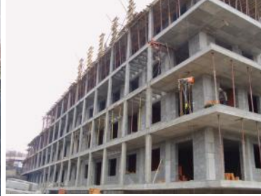
Belgrado, „Kanarevo Brdo“, edificio residencial con eficiencia energética – placas de entrepiso y revestido Simprolit, bloques de fachada y para tabiques, placas SOP para el aislamiento térmico de las columnas y consolas de balcones, monolito Simprolit para el techo.
