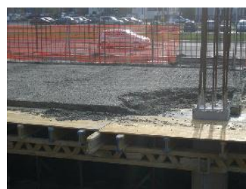
Belgrado, monolito Simprolit bajo la placa de entrepiso de los garajes subterráneos en cualidad de contrafuego y aislamiento térmico
