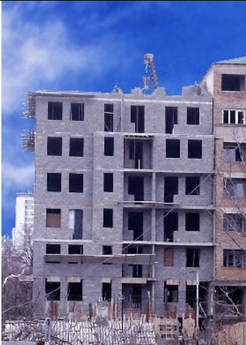
Belgrado, Zvezdara, edificio de ocho pisos con las paredes de carga hechas de bloques Simprolit sin columnas y vigas adicionales, bloques Simprolit, placas SOP y monolito Simprolit.
