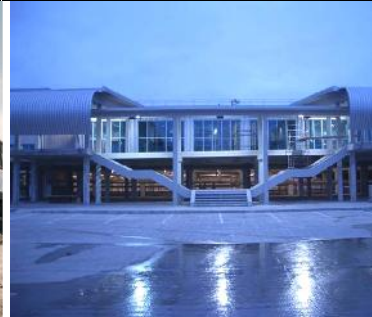
Chukotka , aeropuerto Anadyr, bloques Simprolit, placas SUP, placas de entresuelo y aislamiento térmico de techos Simprolit
