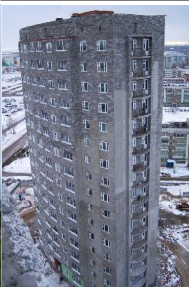
Naberezhnye Chelny, Tatarstán, bloques de fachada y para los tabiques Simprolit – 2 edificios de 16 pisos con el área total de 15.000 2
