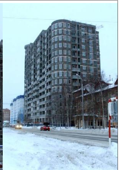
Nizhnevartovsk, Siberia, edificio residencial con el área total de 20.000 2 - bloques de fachada y para los tabiques Simprolit, placas SUP y monolito Simprolit
