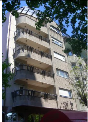
Belgrado, edificio residencial hecho de bloques Simprolit y placas SUP, el revestido del primer piso en mármol.
