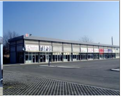
Belgrado, Zemun, centro comercial chino y almacén de aduana, construcción metálica de carga y fachada de bloques.
