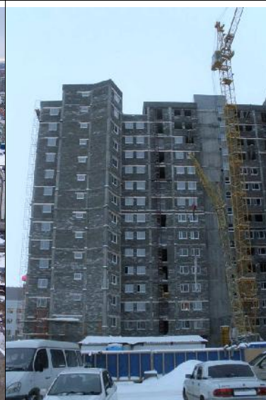
Nizhnevartovsk, Siberia, edificio residencial con el área total de 20.000 2 - bloques de fachada y para los tabiques Simprolit, placas SUP y monolito Simprolit
