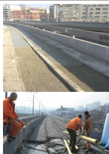
Belgrado, „Autocomanda“, puente para peatones y tranvías, monolito Simprolit
