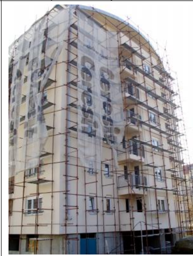
Belgrado, zona residencial „Stepa Stapanovich“, placas SOP Simprolit sobre los garajes subterráneos.
